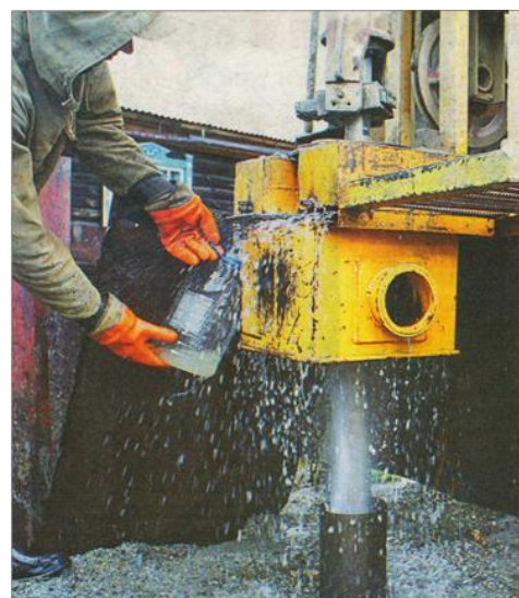
Бурение скважины под воду. Фото из архива Андрея Баздырева
